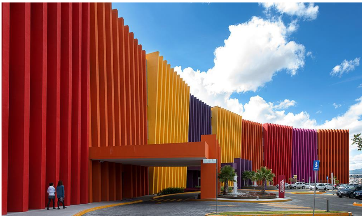
Imagen 14. Hospital Infantil de Oncología Teletón (HITO) en la ciudad de Querétaro, obra de Sordo Madaleno Arquitectos. (Navarro, J., 2013)
