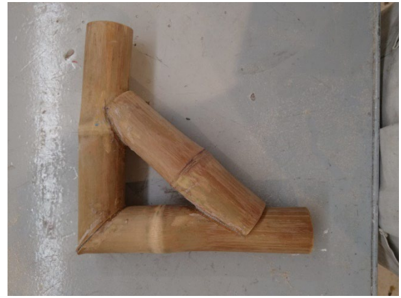
Fig. 13. Conexión en esquina. Elaboración Propia.
