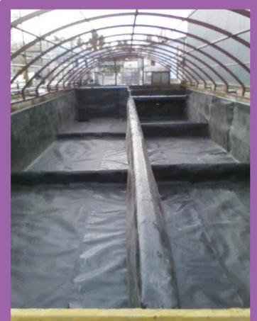
Figura 2: Arpimix. (2021). *Fosa de Retención de Ácidos Recubierta con GMB HDPE*. Recuperado de: <https://arpimix.com/hellomotoiden-5/>
