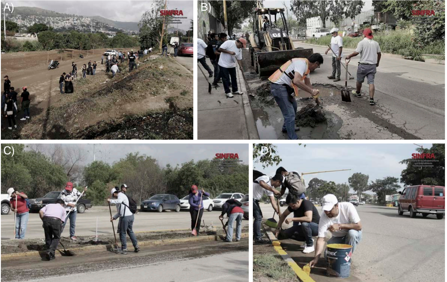
IMAGEN 6. 6. A) Limpieza del río Atoyac y zona del mercado 6. B) Rellenaron baches de las vialidades en las vialidades aledañas al mercado 6. C) Limpieza de vialidades 6. D) Limpieza y pintura en vialidades. (secretaría de las infraestructuras y el ordenamiento territorial Sustentable, 2019)
