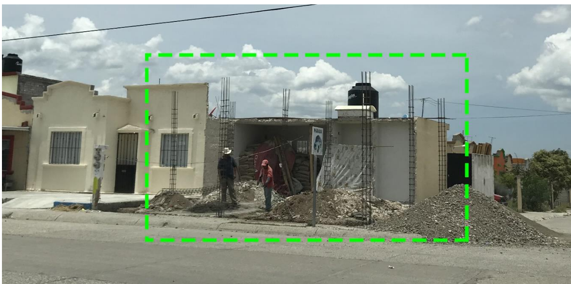
Fotografía 6. Modificación de vivienda unifamiliar "Fraccionamiento Ciudad Yagul"
