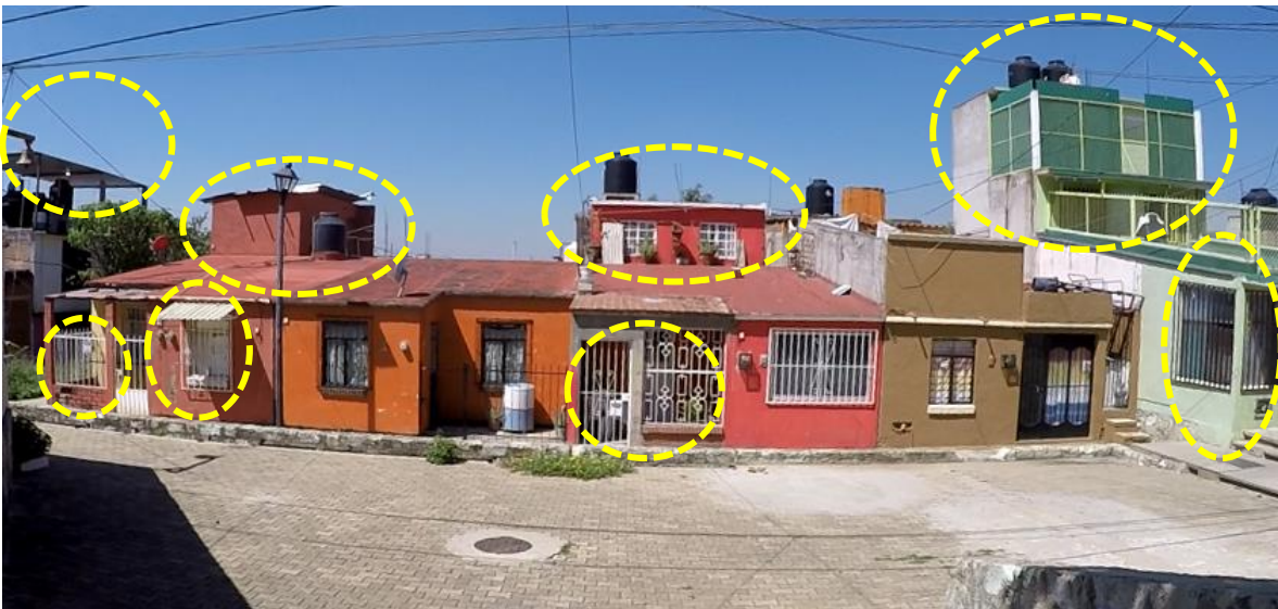
Fotografía 5 Diversidad de modificaciones de viviendas en “Infonavit 1ro de mayo”.
