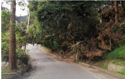
Vías sin aceras peatonales ni iluminación
