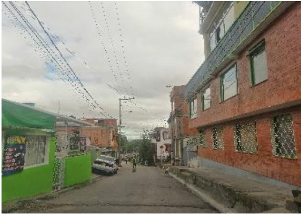
Imagen No. 7. Estado actual de calles
