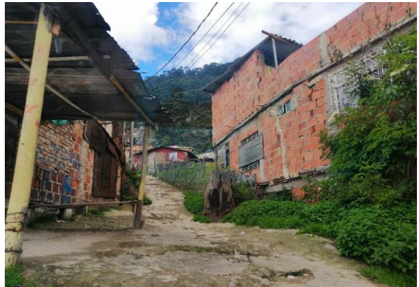
Imagen No. 12. Vía peatonal sin pavimentar
