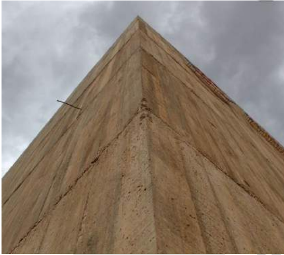
Fotografía. Materialidad en Fachada Principal, Centro Cultural Teotitlán del Valle. Fuente: Gerardo Corres
