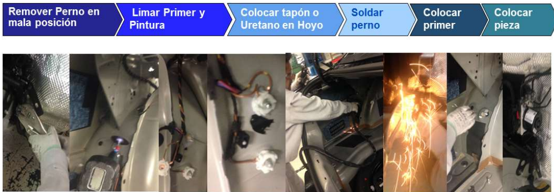
Figura No. 33. Proceso de colocación de nuevos pernos
