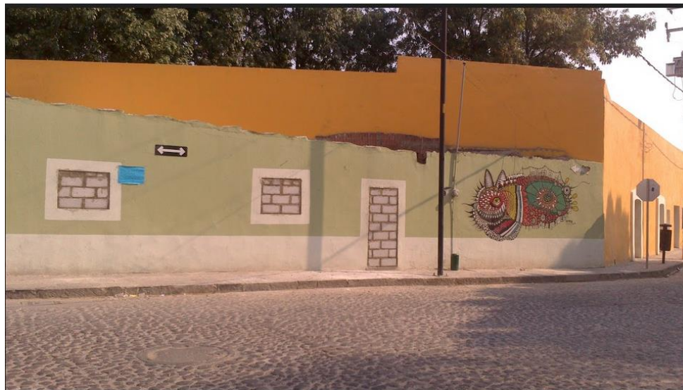
Figura 10. Fotografía de la primera casa desalojada y recién clausurada para su acceso. Fuente: Elaboración propia
