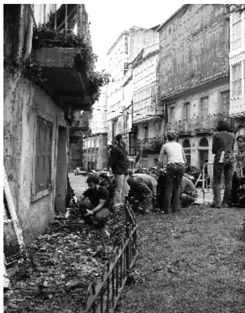
Fig. 1. Ferrol Vello: recolección de materiales desprendidos de una casa en ruinas. (Foto de los autores)
