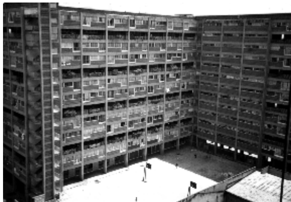
Fig. 1. Centro Urbano Presidente Alemán (más conocido como Multifamiliar Alemán), ciudad de México. Vista de conjunto. (Foto: Acervo Lab. Audiovisual, Inst. Mora)
