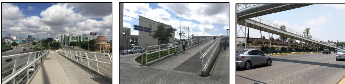
Imagen 11, 12 y 13. Rampas de acceso
