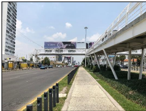
Imagen 14 y 15. Delimitación entre parque y carriles vehiculares
