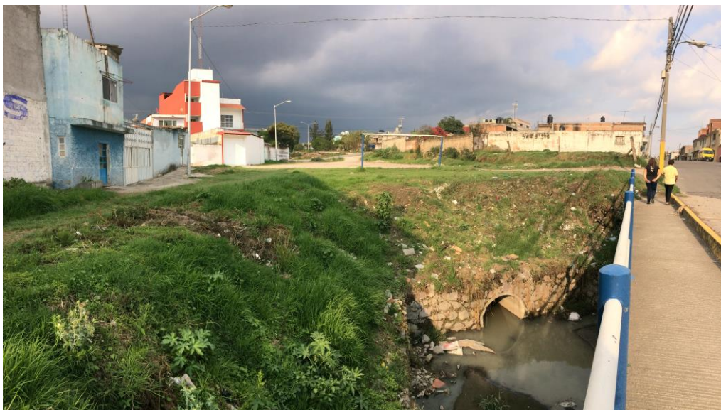
Ilustración 22. Último tramo entubado de la calle Xaltonac. Fotografía tomada por la autora el 3 de junio de 2017.
