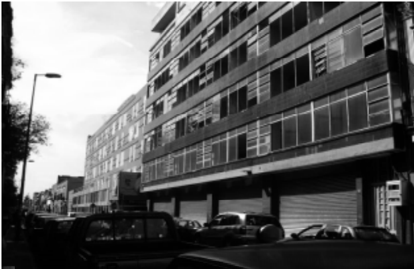
10. Puebla. Edificios abandonados y “nuevas centralidades” en el ámbito de la Ciudad Histórica.
