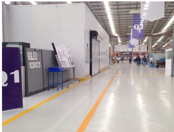
Figura 4.4. Espacios seguros y tableros en instalaciones
