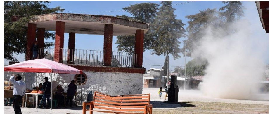
Imagen 1.3: Fotografía del estado actual de la cancha en Plaza Principal de San Miguel Espejo. Se visualiza una polvareda generada por los fuertes vientos en la zona la calidad de la materialidad del sitio. (Taller de Consolidación en Arquitectura, 2017)
