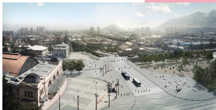
EXPLANADA PATRIMONIAL Y PARQUE MAPOCHO. IMAGEN CORTESÍA DE DUPLA ARQUITECTOS
