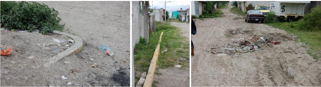
Ilustración 5.Estado Físico de la Vía Pública. (Autoría, 2015)
