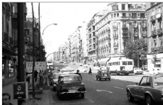
Fig. 7. Madrid. Transformación de la calle Velázquez: antes (arriba) y después (abajo). (Fotos del autor).
