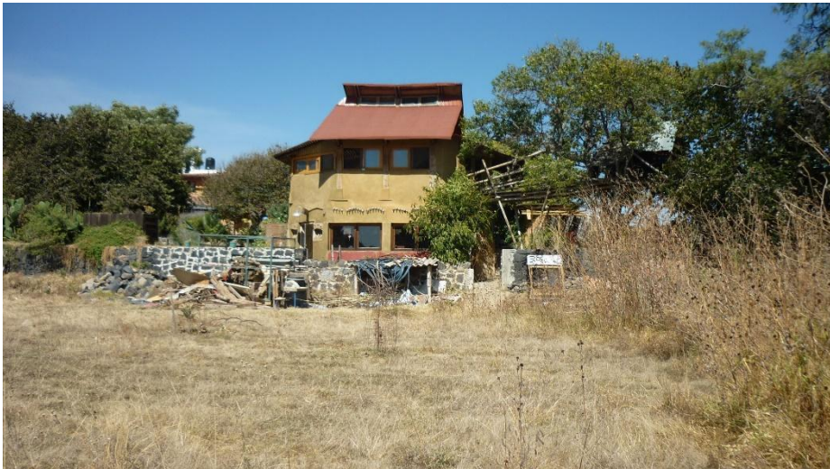
Figura 4. Vista del terreno en Casita de Barro; al Norte
