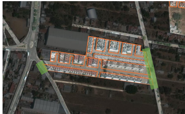
Google (s.f.). [Fraccionamientos ID:47, ID:53 e ID:54]. Recuperado en octubre del 2020
