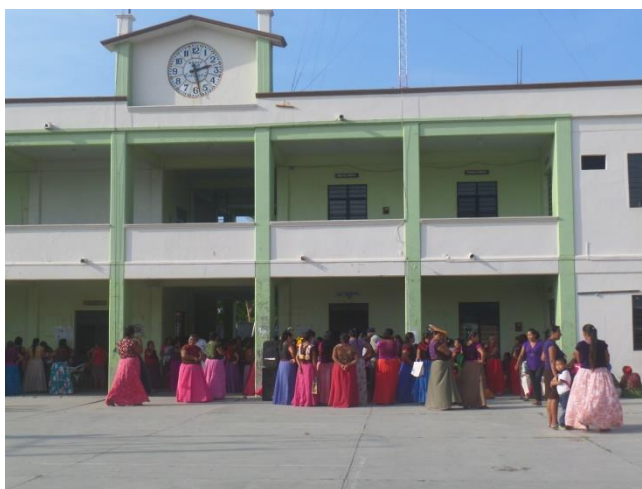
Fotografía 2. Palacio municipal de San Mateo del Mar, Oaxaca
