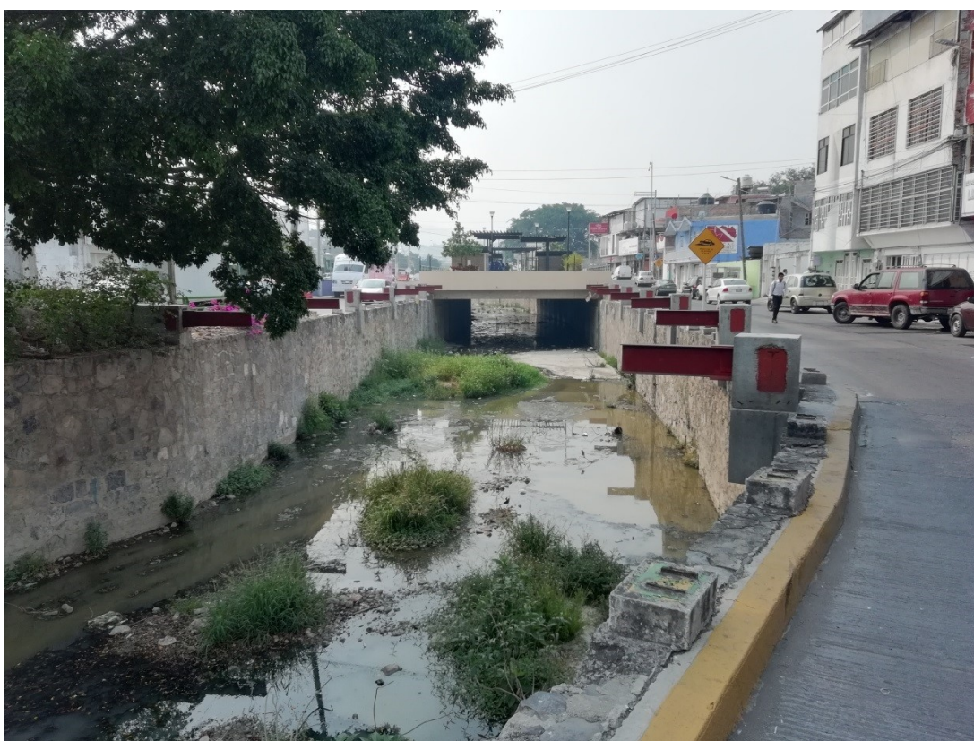
Ilustración 12. Ciclovía inconclusa vista de norte a sur en el paseo Alejandro Cervantes Delgado entre la calle Encino y la calle Francisco I Madero. Fotografía tomada por el autor el 17 de mayo de 2019.
