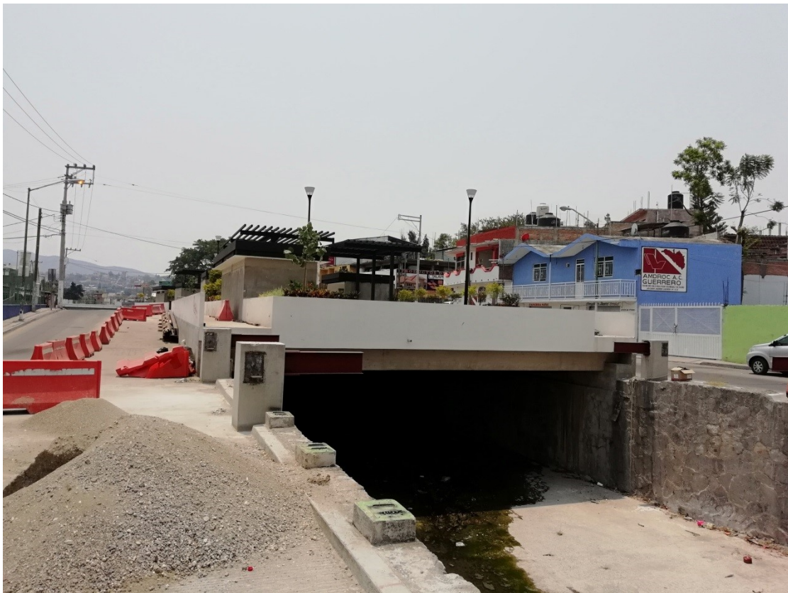
Ilustración 3. Proceso de ejecución de la obra del PLH. Fotografía tomada por el autor el 22 de abril de 2018.
