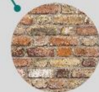
Uso de ladrillo
