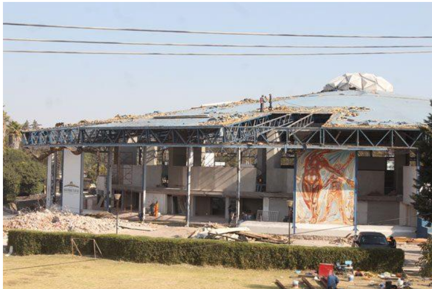
Polideportivo BUAP en remodelación
